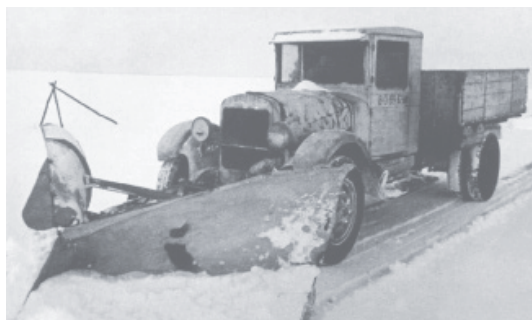
Очистка ледовой трассы «Дорога жизни» грейдером
