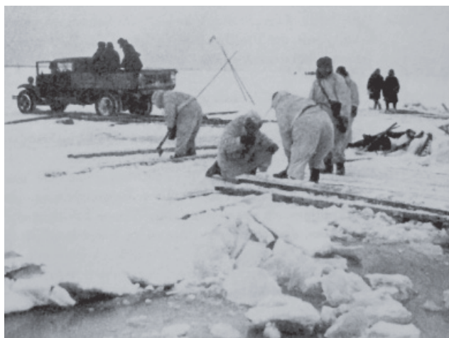
Прокладка деревянных настилов через полынью на льду Ладожского озера
