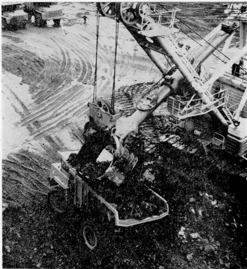
Строится Нерюнгринский разрез
