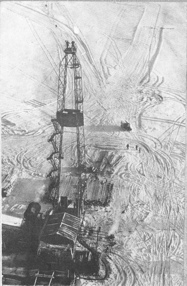
Передовая буровая установка скважины № 52 александровской нефтеразведочной экспедиции глубокого бурения
