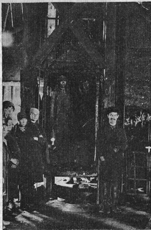
Верхняя приемочная площадка. Спуск в шахту в клетке.
