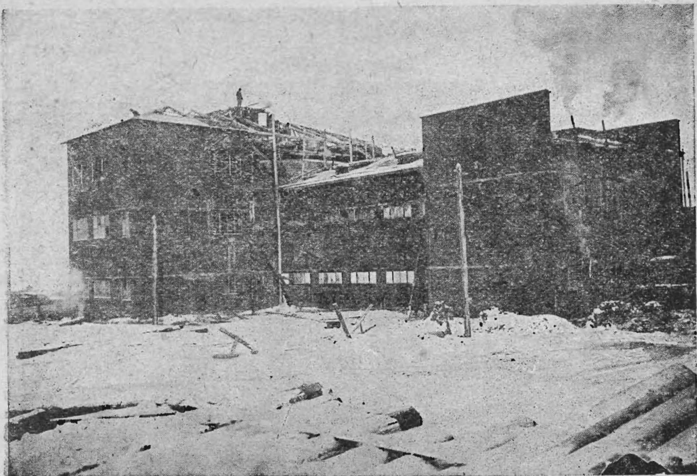
Рис. 8. Кемеровский коксохимический завод Союзконса. Новое здание завода управления.
