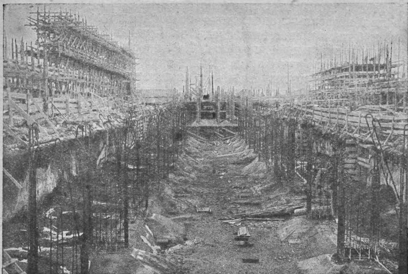
Рис. 5. Кемеровская теплоэлектростанция. Котлован водонасосного отделения.
