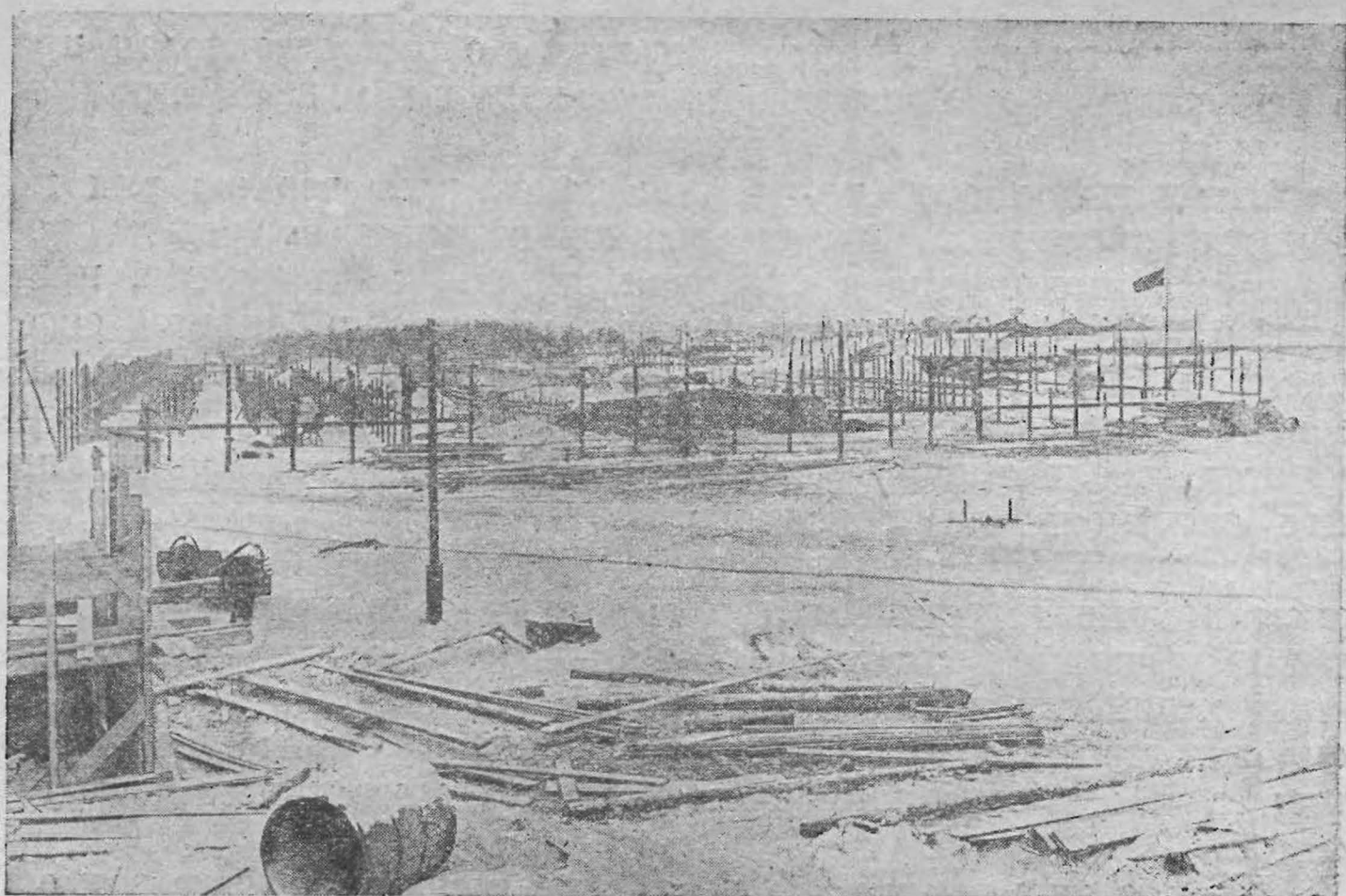
Рис. 4. Кемеровская теплоэлектростанция. Тепляк водонасосного отделения, в котором крепнут железобетонные опоры.
