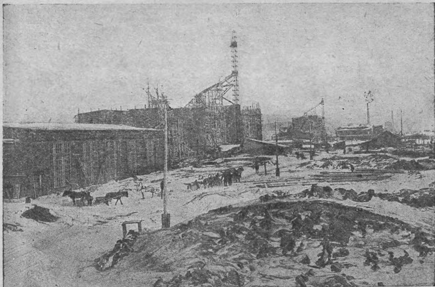
Рис. 9. Кемеровский коксохимический завод Союзконса. Постройка здания рекупераций и бензольного отделения.
