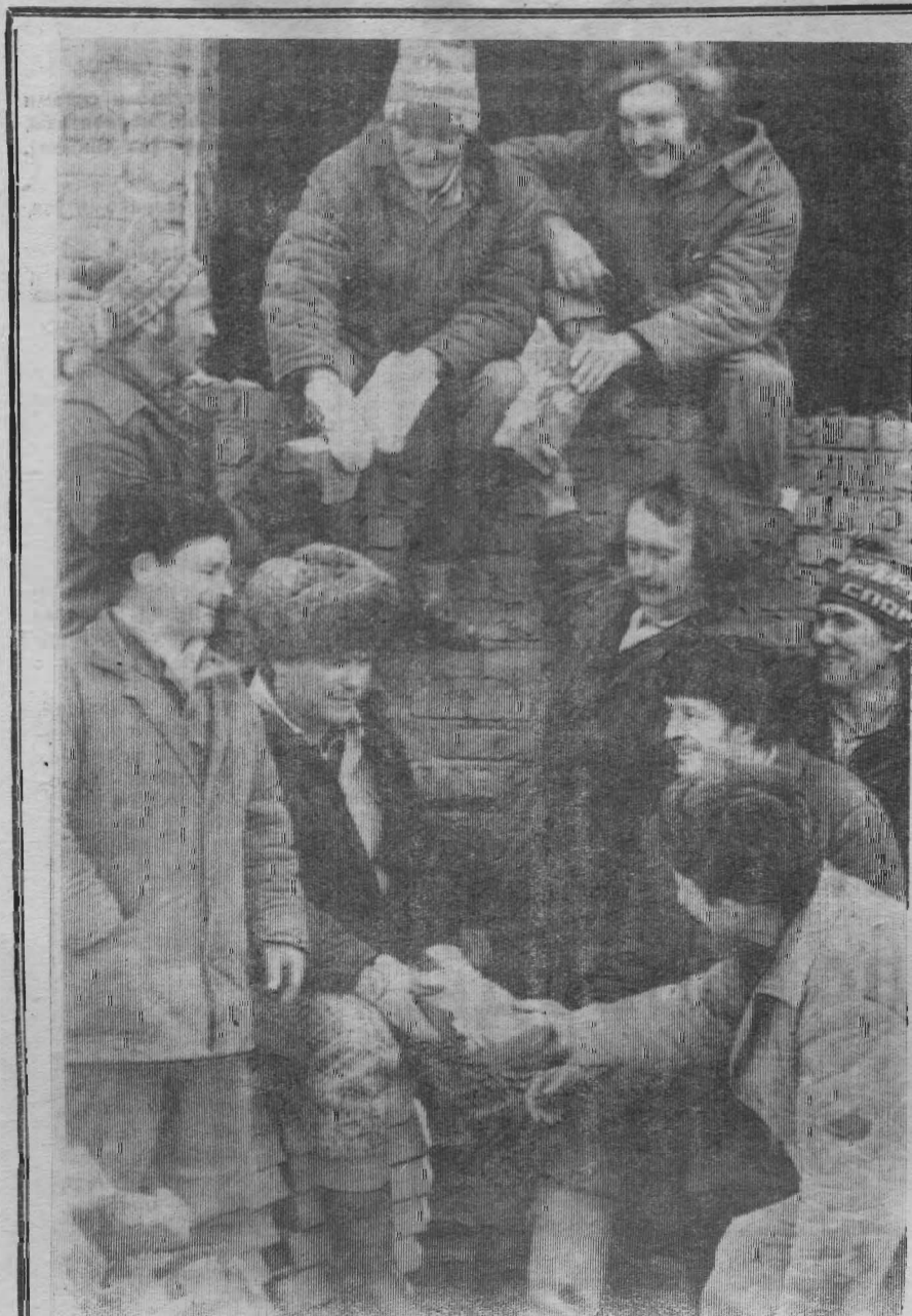
В эти дни комплексная бригада строителей из ПМК-291, которой руководит А. В. Позин, работает на возведении терапевтического корпуса райбольницы. Рабочие успешно выполняют планы, у них высокая производительность труда. В составе бригады каменщики В. Шурин, В. Гвоздев, В. Князькин, Н. Макаренко и другие.
