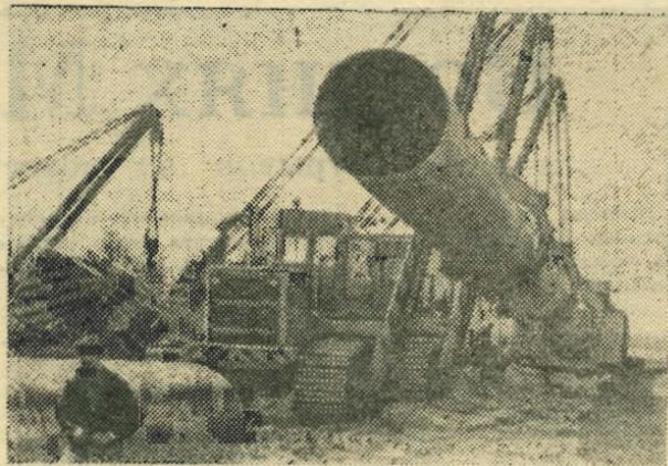
ТЮМЕНСКАЯ ОБЛАСТЬ. Продолжается освоение Уренгойского газоконденсатного месторождения. Отсюда берет начало газопровод Уренгой-Новопсков, входящий в систему крупнейших магистральных трубопроводов Западная Сибирь — Центр. Сейчас здесь идет изоляция труб диаметром 1420 мм. Одновременно со строительством этой магистрали коллектив тру-
