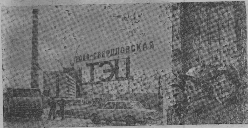
Свердловская область. ТЭЦ бригада монтажников которой руководит коммунист Н. К. Ивакин. Передотельство Ново-Свердловской треста «Уралэнергоустановка», вой коллектив, выполнив-
