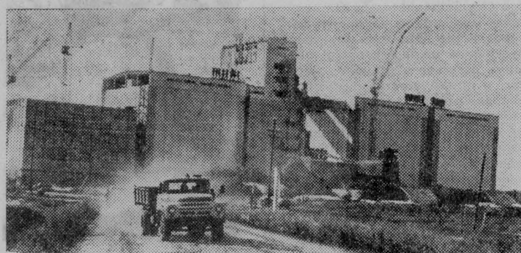
ОМСКАЯ ОБЛАСТЬ. В райцентре Москаленки сдана в эксплуатацию первая очередь элеватора. В этом году от хлебозеробов Москаленского района сюда поступит 89 тысяч тонн зерна.
