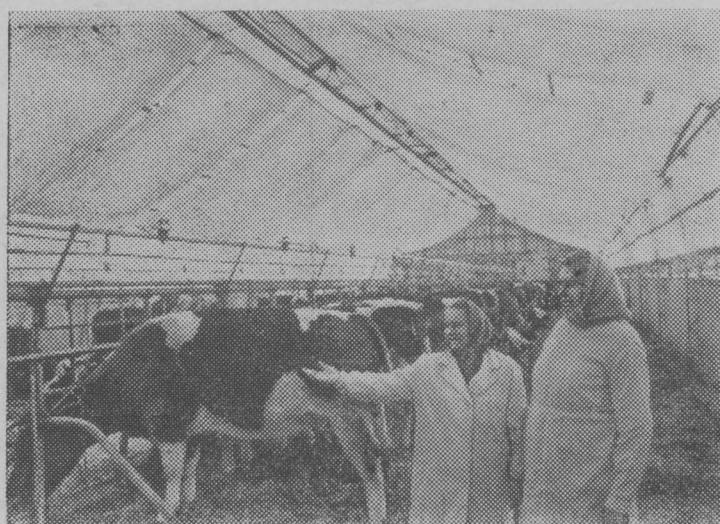
**Киевская область.** В опытном хозяйстве «Александровка» построен коровник, стены и крыша которого сделаны из синтетической пленки. Такое здание в 3—4 раза дешевле железобетонного и строится быстрее.
