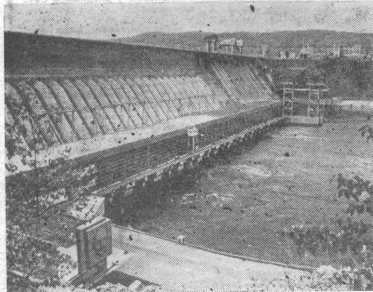
Счетчики Красноярской ГЭС зафиксировали цифру: 150 миллиардов. Столько киловатт-часов электроэнергии выработала станция почти за 10 лет работы. На Красноярской ГЭС установлено 12 агрегатов мощностью по 500 тысяч киловатт каждый.
