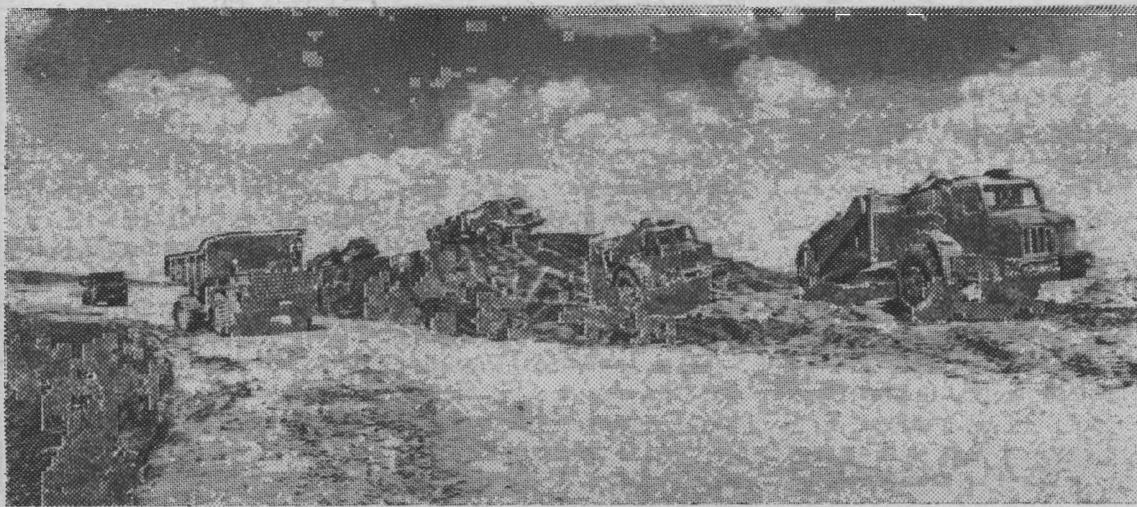
«В Алтайском крае приступили к строительству второй очереди Алейской оросительной системы...»
