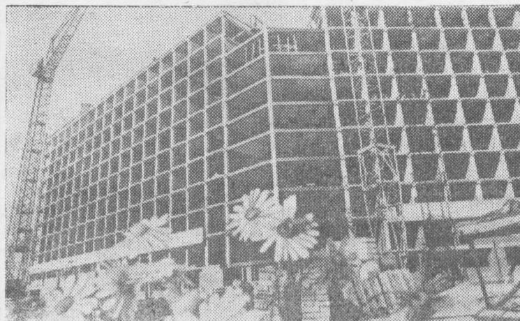
**МОСКВА.** Стойные, ажурные конструкции главного корпуса Всесоюзного кардиологического центра АМН СССР взметнулись ввысь на 10 этажей. Опережая график монтажа каркаса на несколько недель, строители комплексной бригады А. П. Егорова из треста «Мосстрой-31» заканчивают возведение перекрытий 11-го этажа.
