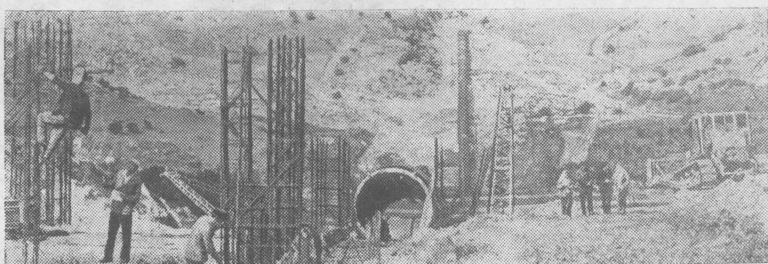
Ставропольский край. В сложных топографических условиях пересеченной местности прокладывается русло третьей очереди Большого Ставропольского канала. Гидростроителям предстоит смонтировать три металлических дюкера и проложить семикилометровый тоннель.
