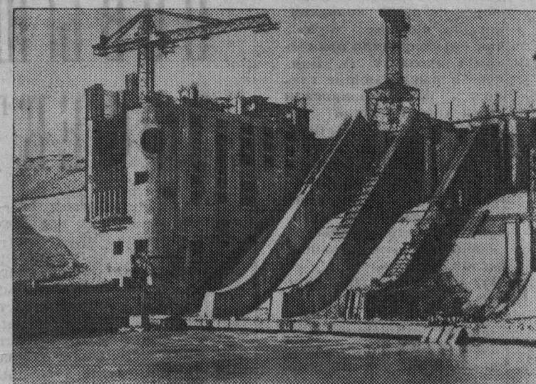
Евфратский гидроэнергетический узел, сооружаемый в Сирийской Арабской Республике при техническом содействии Советского Союза, включает в себя гидроэлектростанцию мощностью 800 тысяч киловатт, плотину высотой 58 метров и длиной 41 километр, высоковольтные линии электропередачи.
