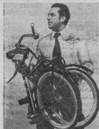
На Пермском велосипедном заводе освоена новая, складная модель велосипеда—«Кама». Колеса машины складываются как книжная обложка. Для этого достаточно, не прибегая к помощи вспомогательных инструментов, открыть и закрыть разъемный замок. В сложенном виде «Кама» умещается в багажнике автомобиля... Специальные регулирующие устройства позволяют изменять высоту руля и седла.
