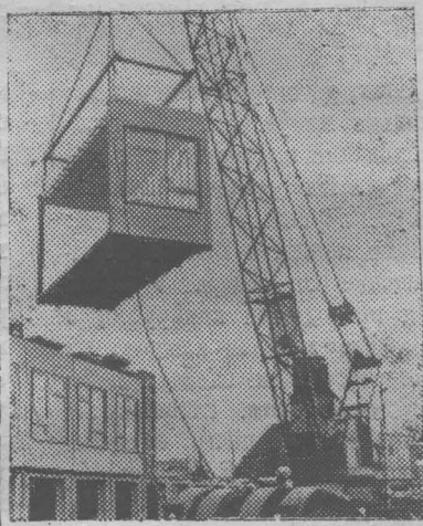
ГДР. От 4 до 6 месяцев требуется строителям для сооружения 3-этажного типового здания для детских садов и яслей из готовых блоков.
