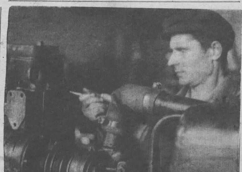
Четкая работа и долговечность двигателя зависит от правильной холодной и горячей обкатки после ремонта. Моторист трактороремонтного завода, коммунист Геннадий Фролович Радченко эту работу выполняет отлично. Кроме этого, ежегодно в уборочную страду поднимается на мостик комбайна. Нынче в колхозе «Родина» уложил в валки хлеба на 431 гектаре, обмолотил — на 47 гектарах.
