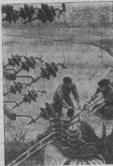
ДРВ. Бригада электриков в провинции Нгеан восстанавливает разрушенную американскими бомбами линию электропередачи. Фото ВИА — ТАСС.
