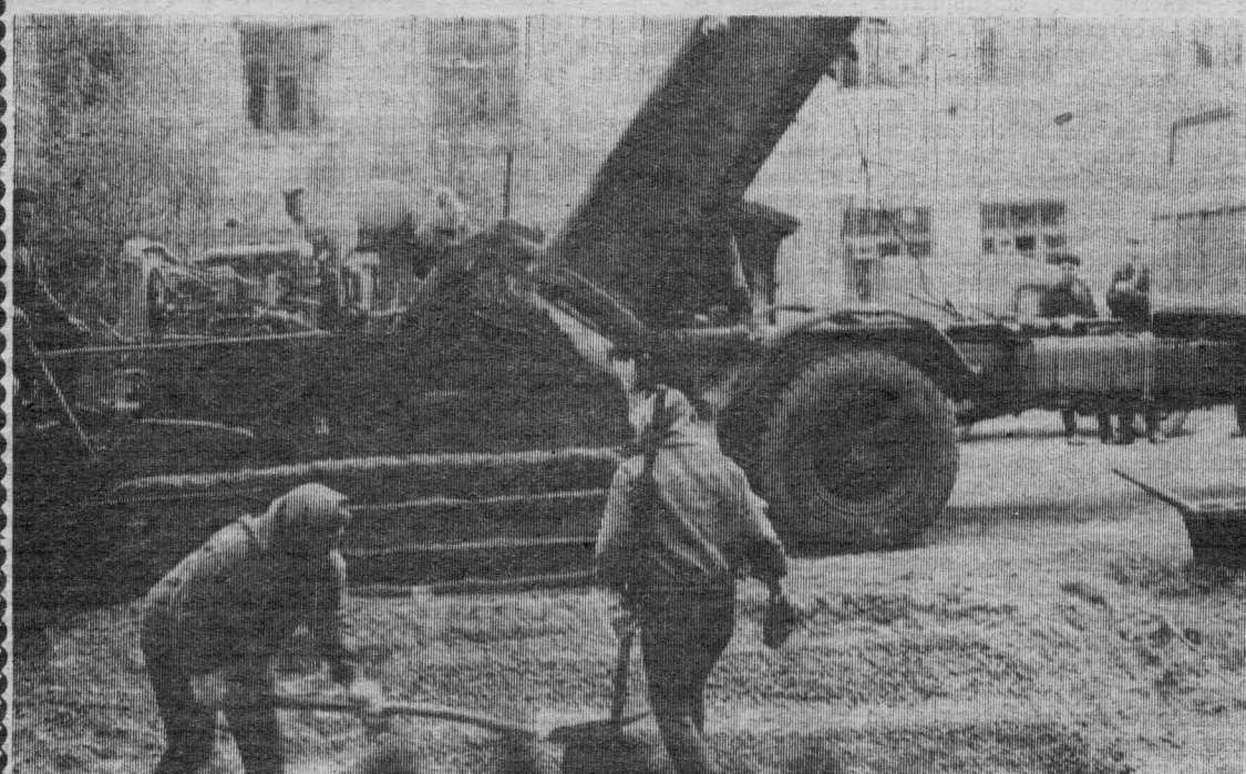
Идет укладка асфальта.
