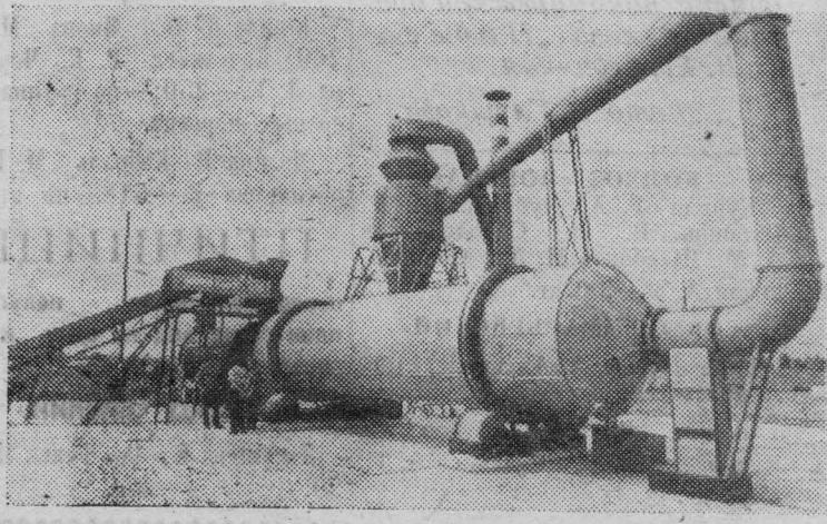
«АСТРА» — так называется созданный на Экспериментальном заводе древесно-стружечных плит и деталей Министерства лесной и деревообрабатывающей промышленности СССР агрегат для сушки кормов — травяной резки, фуражного зерна и предварительно измельченных корнеплодов. Обслуживают агрегат три человека. Его производительность — 2-3 тонны сухого продукта в час. Управление и контроль за работой агрегата автоматизированы и осуществляются с пульта управления.
