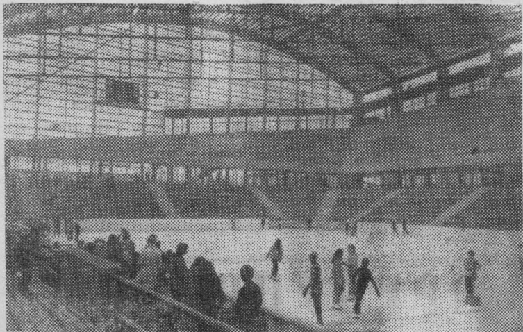
Швейцария. Здание нового зимнего стадиона «Аллменд» построено в Берне специально к чемпионату мира по хоккею с шайбой 1971 года. Он будет проходить здесь с 19 марта по 3 апреля. Трибуны катка рассчитаны на 11 тысяч зрителей. Фото Е. Коржева (Фотохроника ТАСС).
