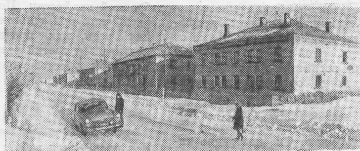
Успешно завершил пятилетку коллектив передового в Челябинской области совхоза «Сугоякский». Прибыль в 1970 году составила 342 тысячи рублей. Многие построены за пятилетие, в том числе детский сад, 2500 квадратных метров жилья, производственные помещения, газифицировано 145 квартир.
