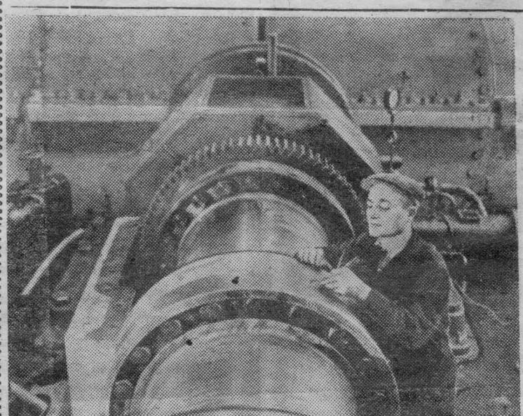
испытания генераторов мощностью 800 тысяч и один миллион киловатт.
