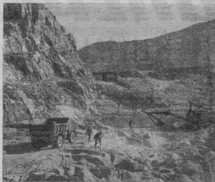
Киргизская ССР. На западе республики, где несет свои воды бурная река Талас, в ущелье горного Киргизского хребта идет строительство Кировского водохранилища. Днем и ночью работают здесь мощные автомобили, бульдозеры, краны, управляемые умелыми руками людей.
