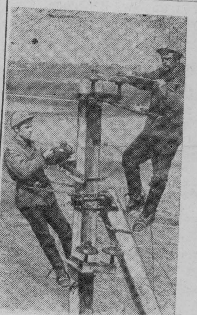
РОВЕНСКАЯ ОБЛАСТЬ. Мачты линий электропередач встретились сегодня во всех районах области. Коллектив механизированной колонны № 22 ведет новые линии в отдаленные полесские села. Электрифицируются жилые дома, производственные мастерские, животноводческие фермы. Только в этом году проведено свыше 500 километров линий электропередач. На снимке: передовые электромонтеры братья Адам и Василий Мороз проводят линию электропередачи к животноводческой ферме колхоза имени Пархоменко Млиновского района.
