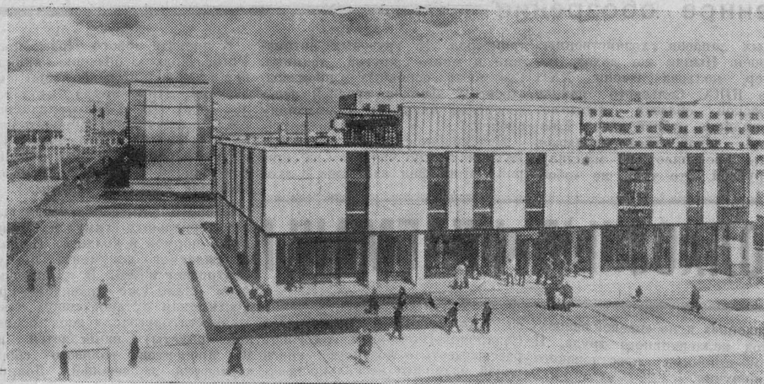
Северо-западный район Челябинска—место массового жилищного строительства. В январе сюда приехали первые новоселы, а сейчас здесь проживает уже около 10 тысяч человек. Строятся и предприятия культурно-бытового назначения. Вступили в строй продовольственный магазин, столовая, парикмахерская, приемные пункты по ремонту обуви, часов, телевизоров, радиоприемников, химчистки.
