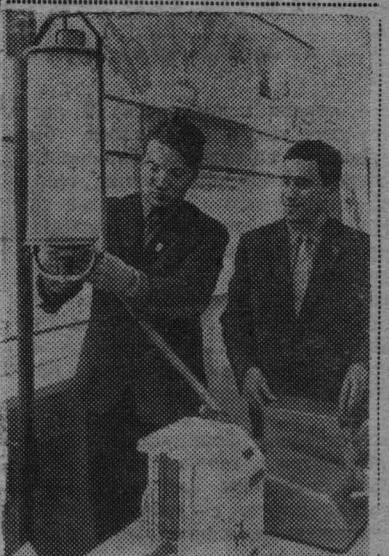
МОСКВА. Во Всесоюзном научно-исследовательском институте электрификации сельского хозяйства в содружестве с сотрудниками Центрального опытного конструкторского бюро Министерства сельского хозяйства СССР создан прибор «МД-1» для учета молока при механическом доении. Он регистрирует количество молока и соответственно выдает чеки. Точность измерения почти стопроцентная. На снимке: главный конструктор лаборатории ВИЭСХ Ф. П. Марьяхин (справа) и механик В. С. Васин проверяют новый прибор. Фотохроника ТАСС.
