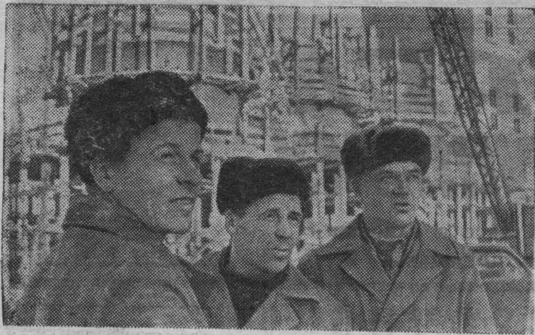
КАРЕЛЬСКАЯ АССР. У подножия Сулажгорских высот, в недрах которых залегают миллионы кубометров сырья, сооружается крупнейший в республике завод силикатных стеновых строительных материалов.
