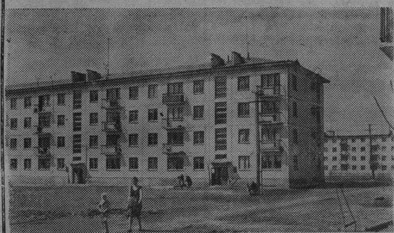
Волгоградская область. 300 квартир со всеми удобствами получили за последние два года рабочие совхоза «Советская Россия». Волгоградский домостроительный комбинат готовит к сдаче еще один дом. Сооружение зданий здесь ведется индустриальными методами.
