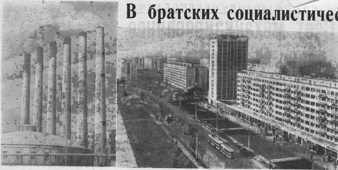
Новый цементный завод «Келм» в Люблинском воеводстве (Польская Народная Республика). Это предприятие выпускает быстротвердеющий цемент «Сапер».
