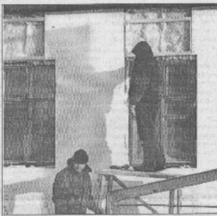
Недавно строители ООО «Сибирь» отремонтировали коррекционную школу-интернат. На снимке вы видите его завершающий этап — обшивку здания интерната утеплителем и стекломагневыми пожароустойчивыми плитами. Кроме того, в интернате заменены электропровода, потолочные перекрытия там, где была опасность их обрушения, система отопления. Работы выполнены на 409 тысяч рублей. Для 73 воспитанников школы-интерната условия жизни стали комфортными и безопаснее.
