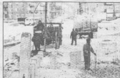
ОБЩИЙ ВИД СТРОЙПЛОЩАДКИ
