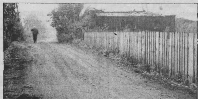
В этом переулке поработала муниципальная техника...
