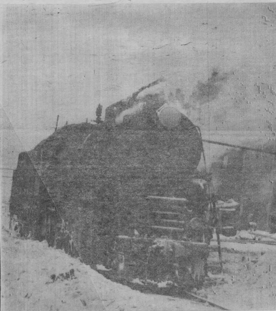
В воскресенье вечером с железнодорожной станции Тайга к Яиской котельной № 1 прибыл паровоз. Мощности его котла решили использовать коммунальщики: для отопления жилья, так как третий котел на котельной № 1 вышел из строя, а четвертый (последний работающий) заснул на кипию и едва теплитя. Паровоз остался на Тайге.
