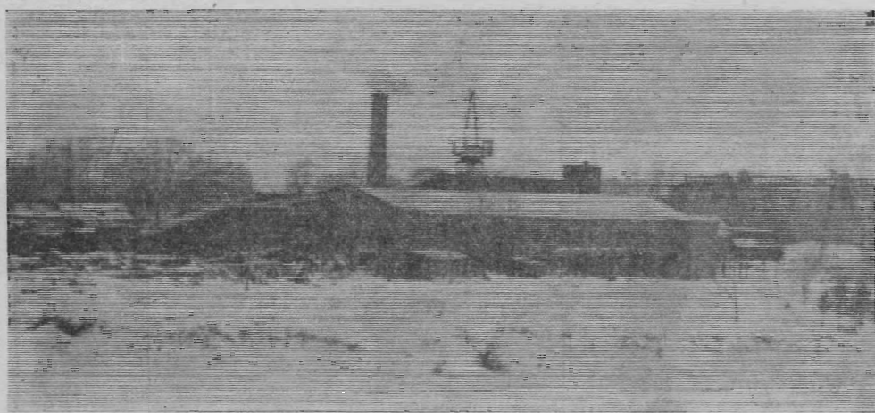
На снимке: «Знаменитая» котельная № 1 акционеров «Ялеса»
