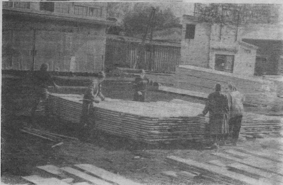
На снимках: лес краном подается в бассейн; бригада Галины Николаевны Гувлевской укладывает пиломатериал для последующей просушки в сушилке.
