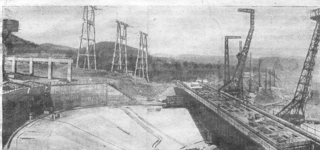
Дивногорск. Мощный наклонный судоподъемник для перевалки судов Енисейского речного пароходства из верхнего бьефа в нижний и наоборот в районе плотины действующей Красноярской ГЭС создают строители.
