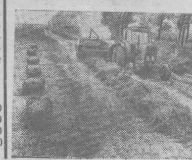
Киргизская ССР. На заводе имени Фрунзе изготовлен опытный образец нового пресс-подборщика. По сравнению с серийной машиной производительность его увеличена в полтора раза, а вес уменьшен.
