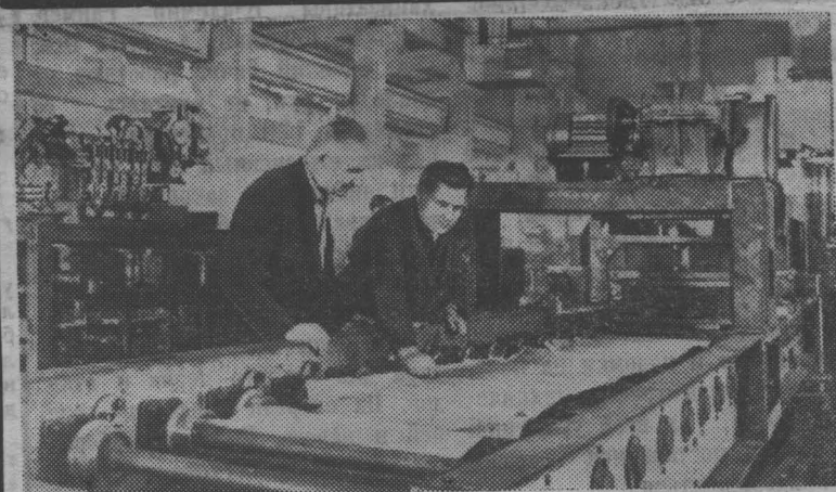
Калининская область. Уникальные автоматические линии и станки изготавливает Бежецкий опытно-экспериментальный завод Министерства тракторного и сельскохозяйственного машиностроения. Сейчас в сборочном цехе отлаживается автоматическая линия для отливки гильз цилиндров тракторных двигателей. Она упраздняет ряд трудоемких операций, повышает производительность, позволяет отлить 120 гильз в час.
