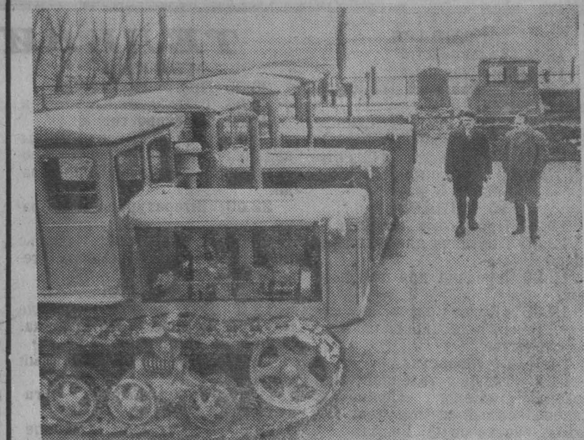
ЛИТОВСКАЯ ССР. При Кайшиядорском районном отделении «Литсельхозтехники» создан специальный обменный фонд тракторов. Хозяйство не ждет, когда будет отремонтирована вышедшая из строя машина, а получает в отделении другую. Новая форма обслуживания колхозов и совхозов способствует более производительному использованию техники. Отделение досрочно выполнило годовой план ремонта тракторов.
