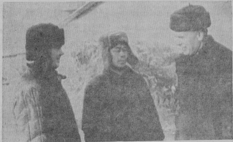
На снимке: М. Жилинский (справа) беседует со строителями.
