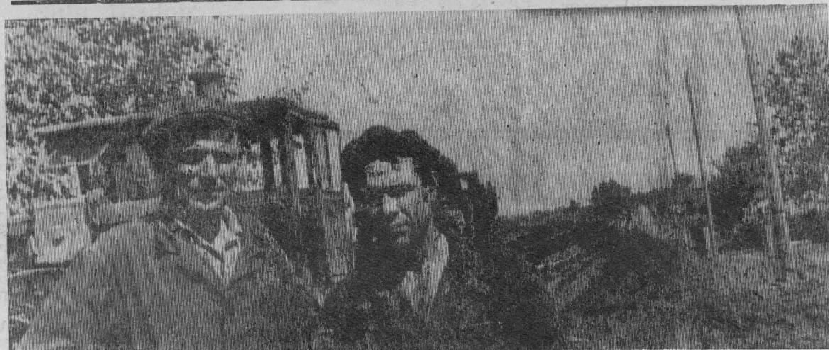
На шестой ферме совхоза «Заря» ведется строительство водопровода протяженностью 2600 метров. Хорошо работают экскаваторщик Ф. Г. Руденко и бульдозерист Н. П. Бузынин.
