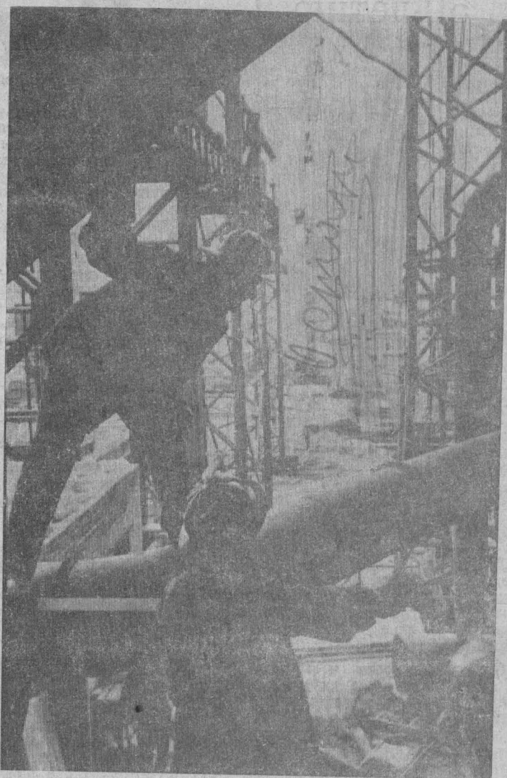
На снимке: Записи строятся. Монтажные сооружения главного корпуса кислородно-конвертерного цеха. Снимок В. Нафо. Студия «Кузбасс-фото».
