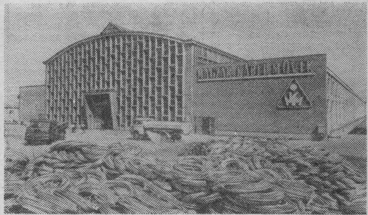
Будапешт. Столичный кабельный завод — одно из старейших венгерских промышленных предприятий. При народной власти здесь произведена модернизация оборудования, выросла производственная мощность завода. На предприятии построен цех, выпускающий еще один новый вид продукции.
