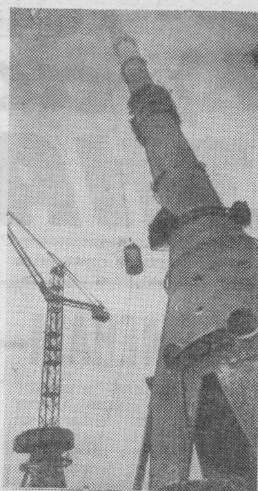
МОСКВА. Монтеры телебашни Останкинской телевизионной башни произвели подъем первой 23-тонной секции, являющейся основанием металлической антенны, которой увенчается высочайшая башня мира. Поднята также вторая секция. После подъема остальных частей антенны высота телебашни достигнет 533 метров.
