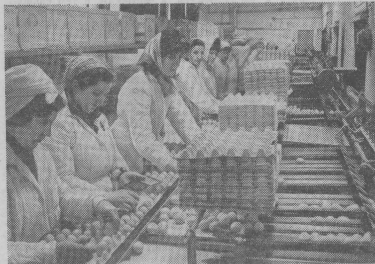
Народная Болгария изготавливает высокопроизводительные машины для механической сортировки яиц. Современное оборудование экспортируется в братские социалистические страны. НА СНИМКЕ: на венгерском предприятии в Тердессентмиклоше. Болгарская машина сортирует более 70.000 яиц в час. Фото МТИ-ТАСС.
