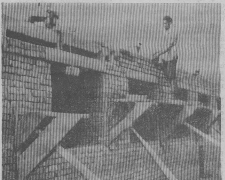
НА СНИМКЕ: бригадир строительной бригады т. Гандылян, для кладки стен примененный простейшее устройство — удобные в работе подмости вместо строительных лесов. Это дает экономию на древесине не менее 500 рублей.
