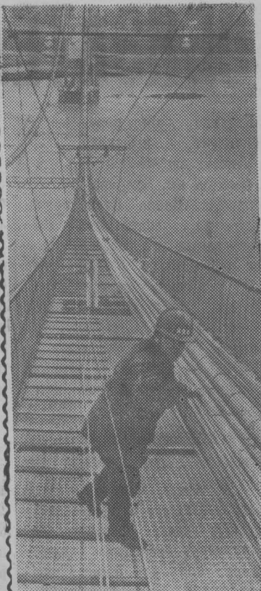
В Англии сооружается второй по длине висячий мост в Европе. Он пересечет реку Северн. Мост будет частью автострады Лондон—Южный Уэльс.
