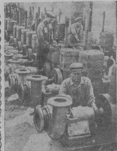
Демократическая Республика Вьетнам. Механический завод в Хай Дуонге. Подготовка к отпавке в деревню водяных насосов.
